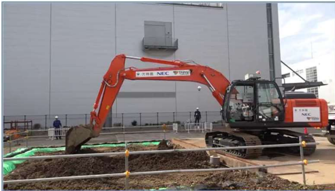
油圧ショベルの自律運転（掘削・積込の自動化）
